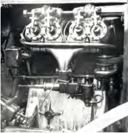
Radový štvorvalec s objemom 5 672 cm³ a výkonom 100 k s ventilovým rozvodom OHC pre závodný špeciál FCR. Dôvodom nevidaného zdvíhu boli vtedajšie medzinárodné predpisy pre jednotlivé kategórie, jeden z nich obmedzoval vrtanie na ø 85 mm.
