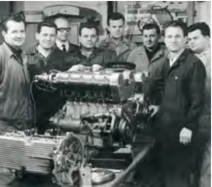
V Česane postavili v roku 1958 štyri motory ŠKODA 1100 OHC s výkonom 92 k pre dva spidery a dve kupé.
